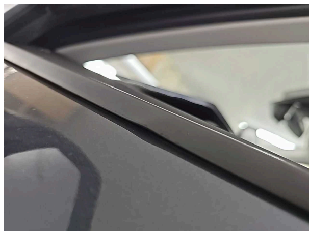
Beschädigung #1: Tür vorn links: Schachtleiste außen - verformt
